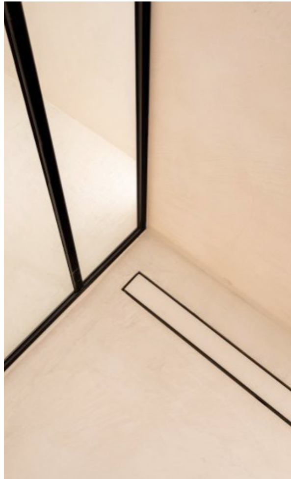
PLATO DE OBRA CON DESAGUE LINEAL
