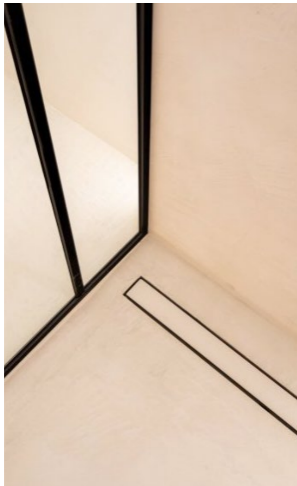
PLATO DE OBRA CON DESAGUE LINEAL
