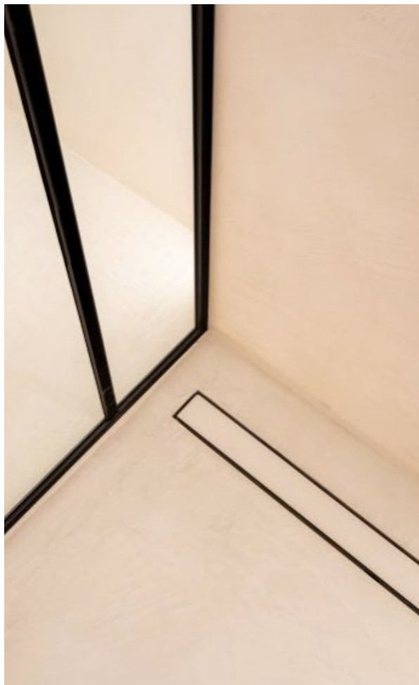
PLATO DE OBRA CON DESAGUE LINEAL
